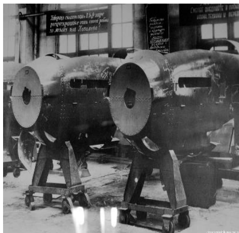
Рис. 5. Изготовление бронефюзеляжа. Механический завод № 207
